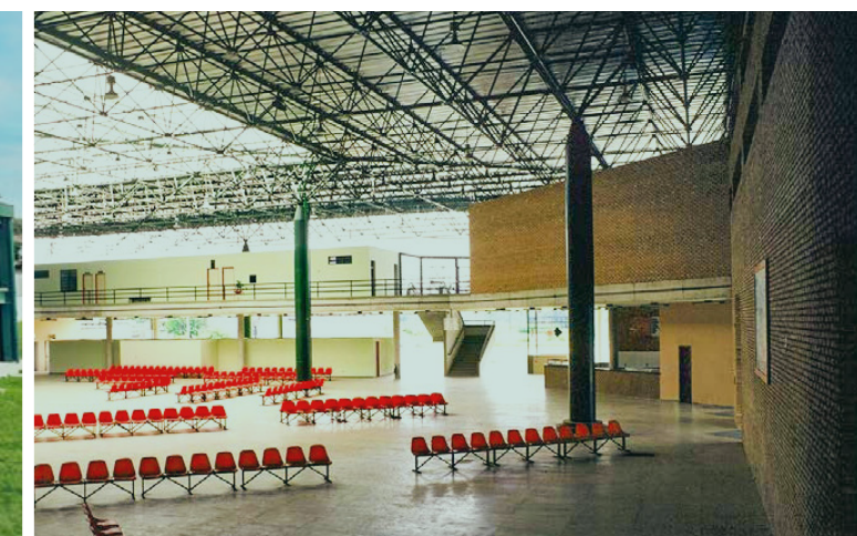
Construção do Terminal Rodoviário - Divinópolis/MG
