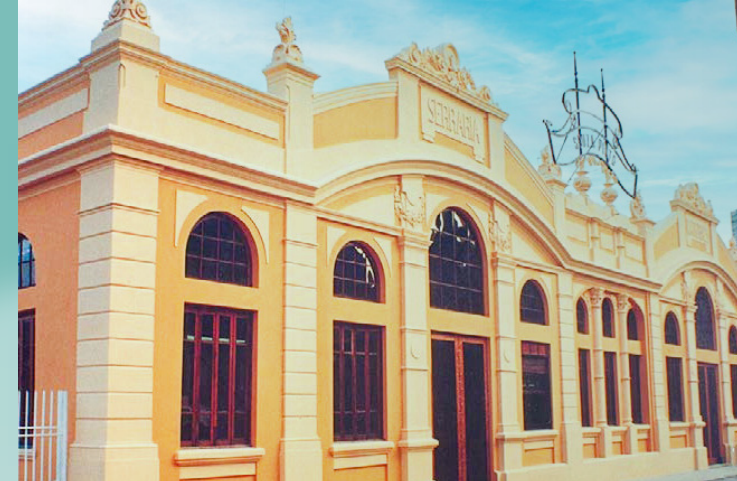
Restauração da Serraria Souza Pinto - Belo Horizonte/MG
