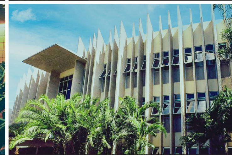
Construção do Paço Municipal - Teófilo Otoni/MG
