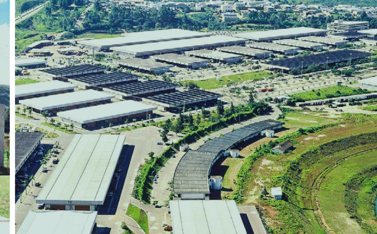
Construção de 11 Pavilhões na CEASA/MG - Contagem/MG
