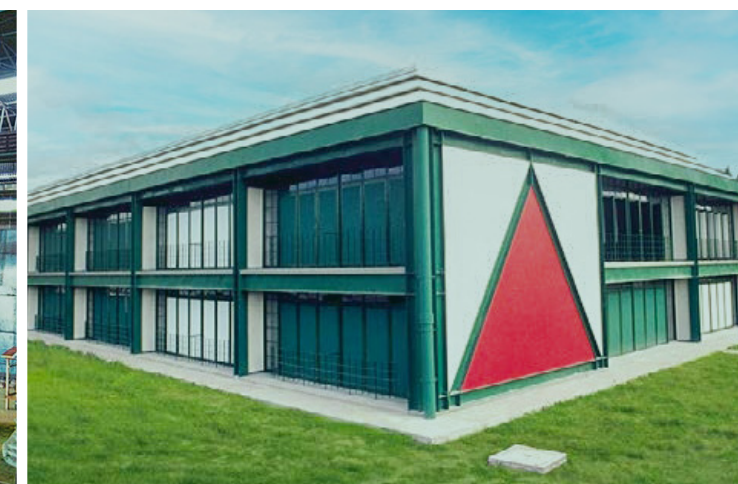
Construção da Escola Estadual (NEEC) - Itaobim /MG
