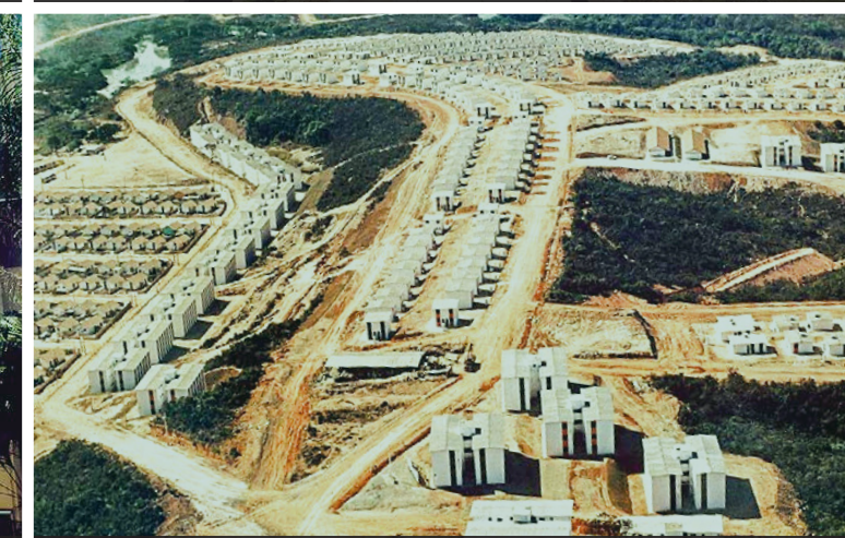
Construção do Conjunto Danilo Passos - Divinópolis/MG
