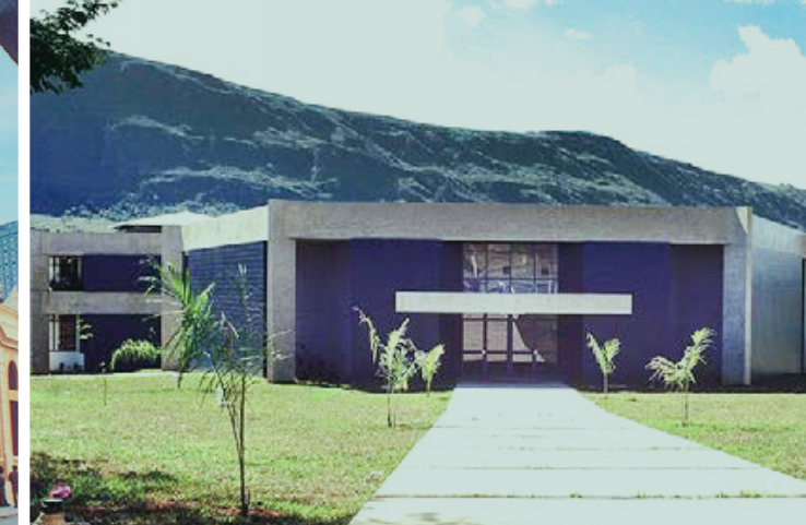
Construção do Sindicato dos Trabalhadores - Ouro Branco/MG
